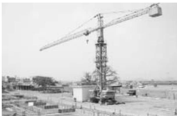
建設中の現場
