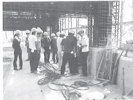
SRC 工事現場見学
