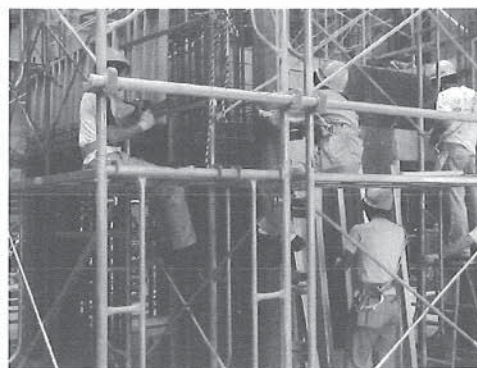
鉄筋コンクリート造施工実習
