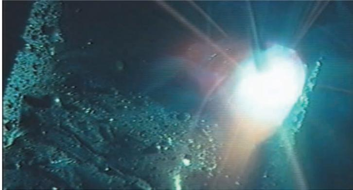
㉑19mm板・4層目1パス目溶接・低電流値（120A）・後退法
