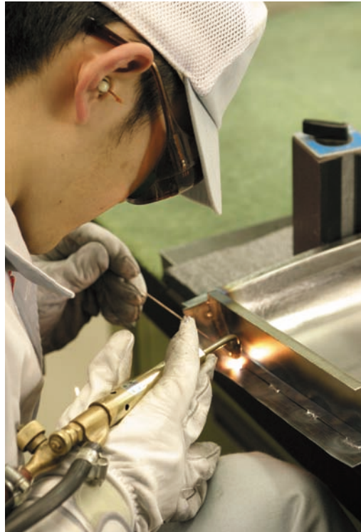
図7 - 130 補助材の本溶接
