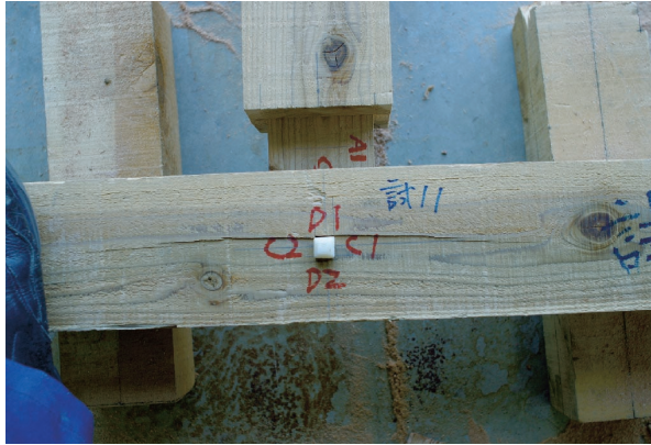
写真1 土台の割裂破壊 (ABS樹脂)
