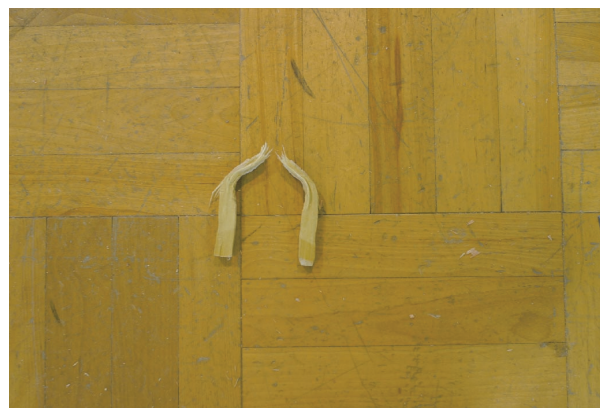
写真6 FFU込栓の破断
