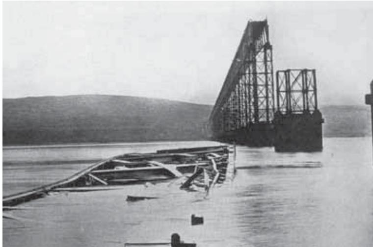
Fig.3 (a) 1879年に崩落した旧ティ鉄道橋
