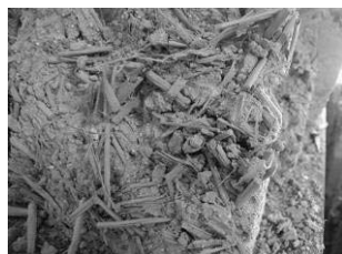
写真-5 荒壁用土 ワラスサ混入状況
