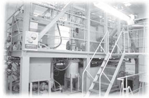
図5 磁石の力で汚れを吸着する処理装置
