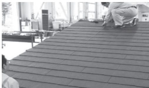
図6. 固定金具位置決め用の墨出し作業
