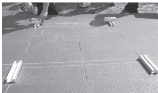
図7. 固定金具の取り付け作業
