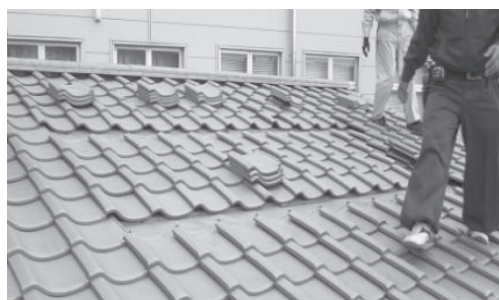
図11. 固定金具の取り付け位置決め
