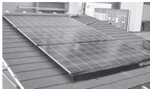
図10. パネルを取り付けた状態
