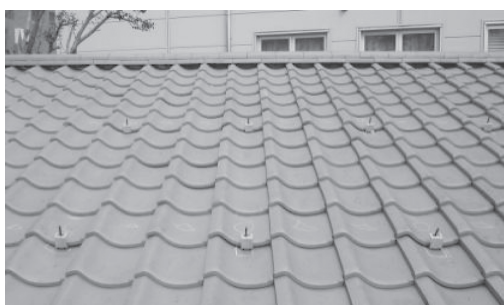
図 13. 固定金具の瓦への納まり
