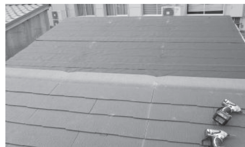
図 5. スレート瓦の葺き作業
