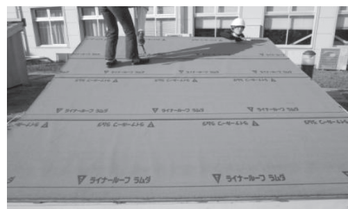
図 4. アスファルトルーフィングの張り作業
