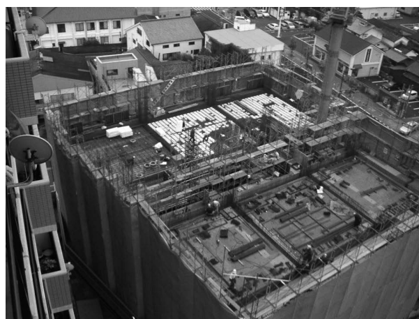
図 11 建設中の新築マンション工事風景
