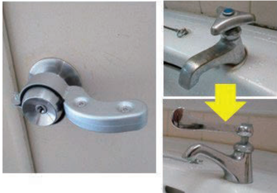
図11 (a) ドアノブ補助レバーの取り付けおよび (b) 洗面台蛇口のレバー式への改善
