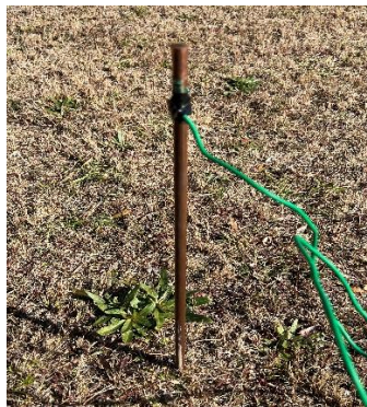
図 4-5-2 接地棒を埋める
