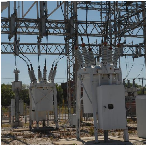
図 1 - 1 - 2 開放型高圧受変電設備
