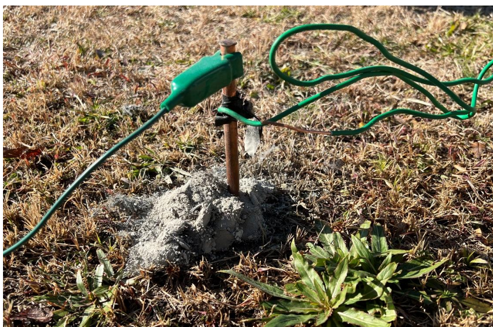
図 4 - 5 - 8 接地抵抗低減材を使用している様子
