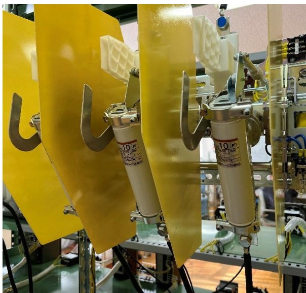
図1-2-6 高圧交流負荷開閉器
